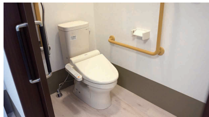
2階 居室トイレ
